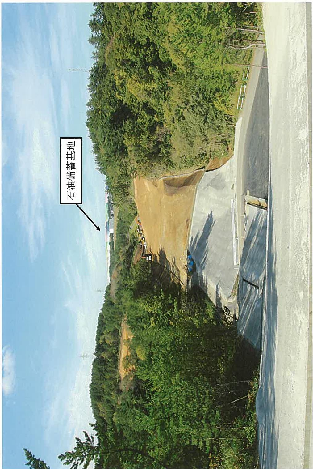
本件敷地の周辺で発生した外部火災が本件敷地内の設計対処施設（別紙図6※1参照）に延焼しないように、燃えるものががない帶状（幅25m以上・全長約8km）の防火帯を設ける。
